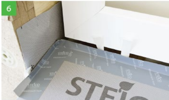
Mise en place de STEICOfix. Astuce: replier les bandes détachables au dos de l'adhésif, elles seront plus faciles à retirer par la suite.
