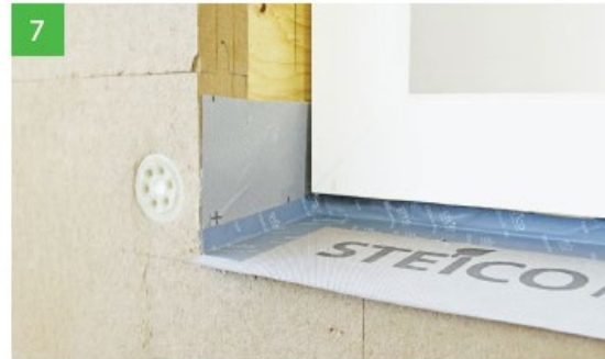
Mise en œuvre du complexe au niveau de l'appui de fenêtre. Liaison des remontées du STEICOmulti tape F avec les tableaux.
