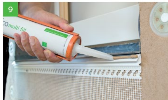
Le rabat de la membrane est collé au profil goutte d'eau du treillis d'armature avec du STEICOmulti fill.
